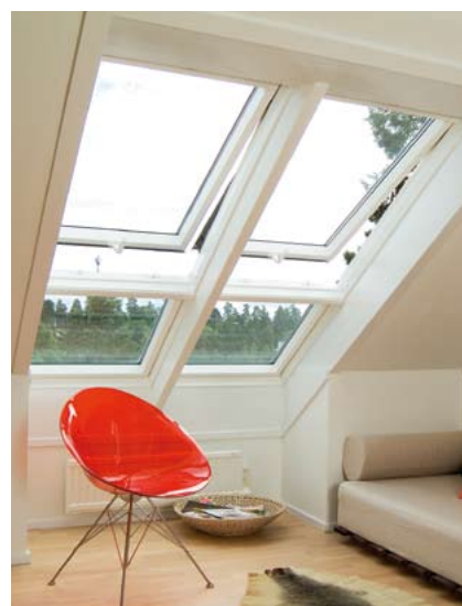
Sammenbygging med to topphengslede takvinduer montert over to faste underelementer. Bruk av hjelpesperre og faste underelementer gir en elegant løsning og større takhøyde i hele feltet.
