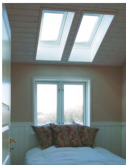
For å slippe å veksle ut taksperrer er det satt inn to vinduer på 55cm bredde (GGU C04).
