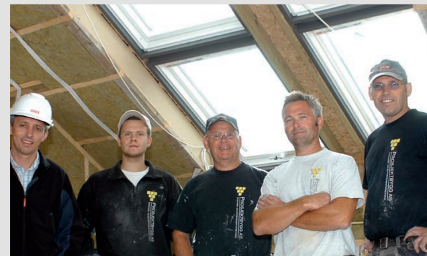
Fornøyd gjeng på byggeplassen under takvinduene fra VELUX, fra venstre; distriktsansvarlig Egil Aarnes i VELUX og Andreas Fillingsnes, Odd Vik, Pål Vik og Espen Vik i Prosjektbygg AS.
