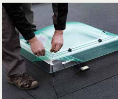
Montering av akrylkuppel
